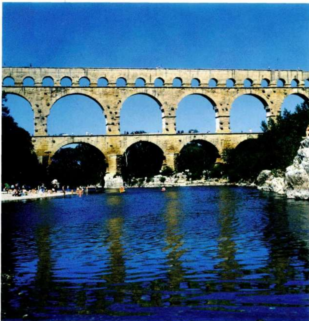
Гарский мост (римский акведук для водоснабжения в Ниме). I в. до н. э. — I в. н. э. Франция.
